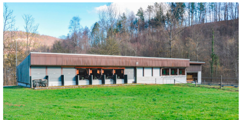
Die Schiessanlage im Gebiet Hefleten zwischen Zunzgen und Tenniken ist die Vereinsstätte des Schiessvereins Zunzgen Tenniken.
